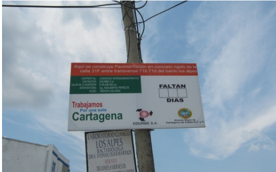
Pavimentacion de la Cra 31f entre transv 71 B y 71D Barrio los Alpes
