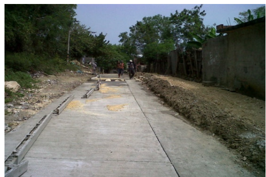
Construcción de Pavimento Rígido en la Calle los Besos entre Calle Caldas y Calle Ruben Bermudez
