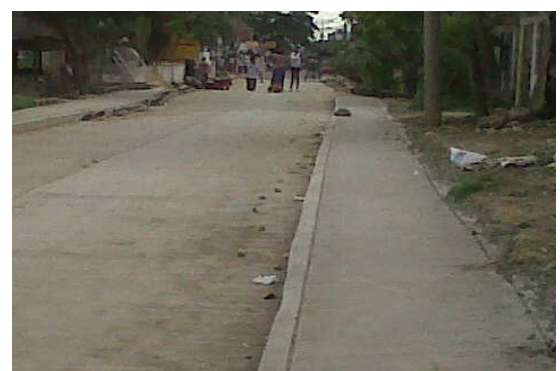
Pavimentacion de la Transv 56 Sector la Islita del Barrio el Pozon
