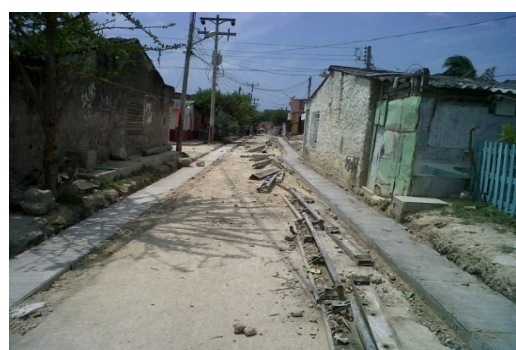
Construcción de cunetas, Andenes y Bordillos Loc: Barrio el líbano Sector Playas de Acapulco Calle las Florez Emplamando con Calle Los Cedros
