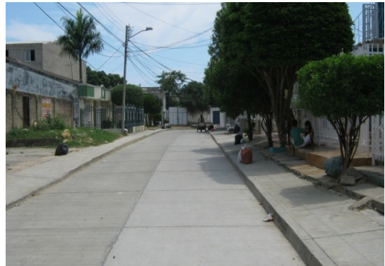
Pavimentacion de la Cra 31f entre transv 71 E y 71B Barrio los Alpes
