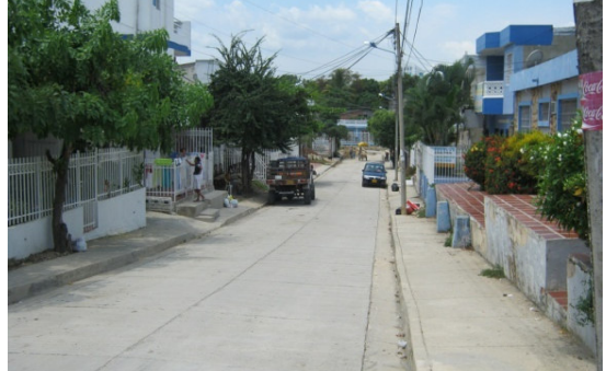
Pavimentacion de la Cra 31f entre transv 71 B y 71D Barrio los Alpes
