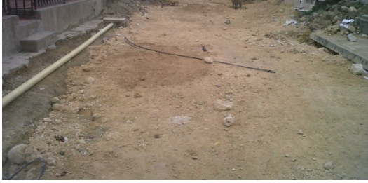
Construcción De Pavimento En Concreto Rígido De La Calle Las Flores, Tramo Entre Canal El Tigre Y Calle La Arrocera, Barrio Olaya Herrera Sector 11 De Noviembre En
