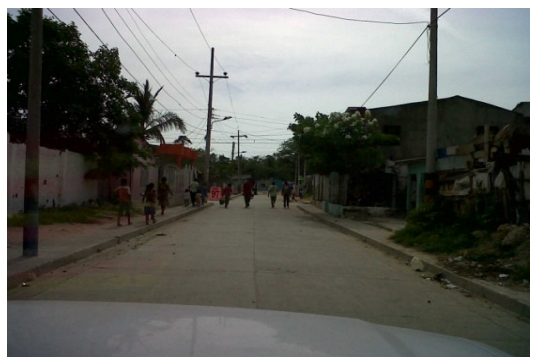
Construcción de Pavimento del Calle entre Calle la Cruz y Canal Amador y Cortez en el Barrio Boston Distrito de Cartagena
