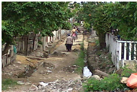
CUNETAS ANDENES Y BORDILLOS DE LA CALLE LAS MELLAS EN EL CORREGIMIENTO DE LA BOQUILLA EN EL DISTRITO DE CARTAGENA
